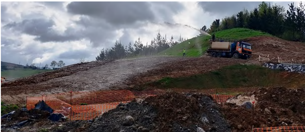
Foto nº39: Hidrosiembra eje-24.
