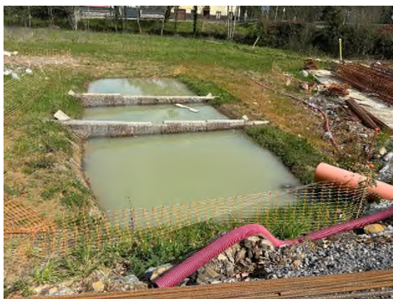
Foto nº24: Balsa de decantación Etxebarria
