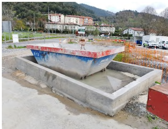
Foto nº28: Limpieza de canaletas en Markina
