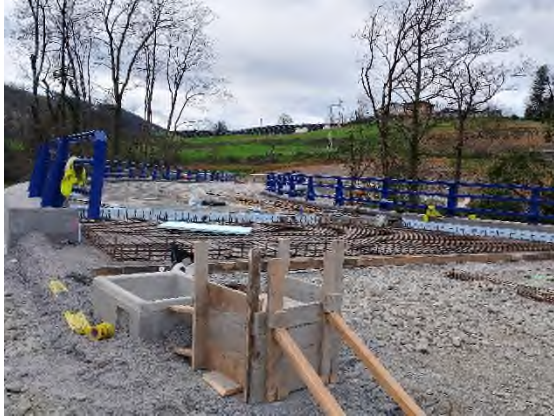
Foto nº5: Ferrallado en estructura-1
