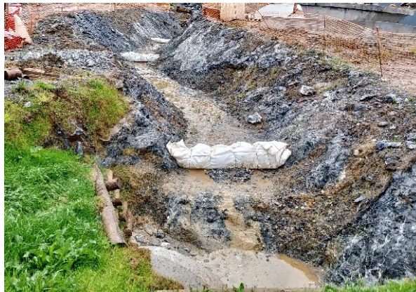
Foto nº22: Barreras habilitadas en ODT-02
