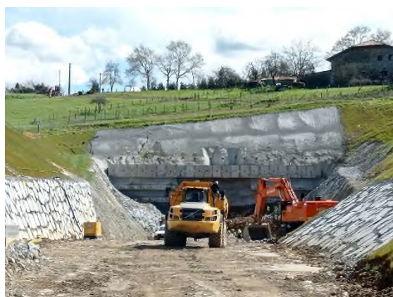
Foto nº1: Excavación emboquille Markina
