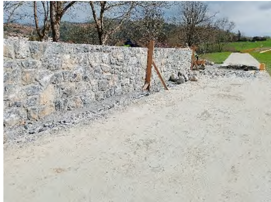
Foto nº8: Eje 19. Muro mampostería
