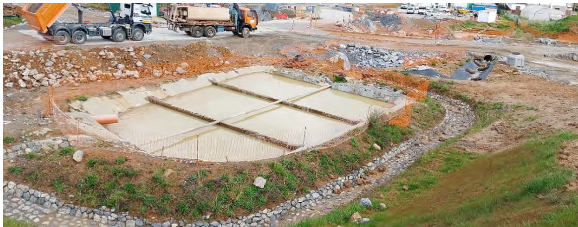
Foto nº43: Vista general de la situación de la balsa de decantación
