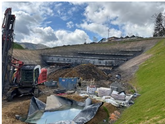
Foto nº30: Balsa de limpieza en Etxebarria
