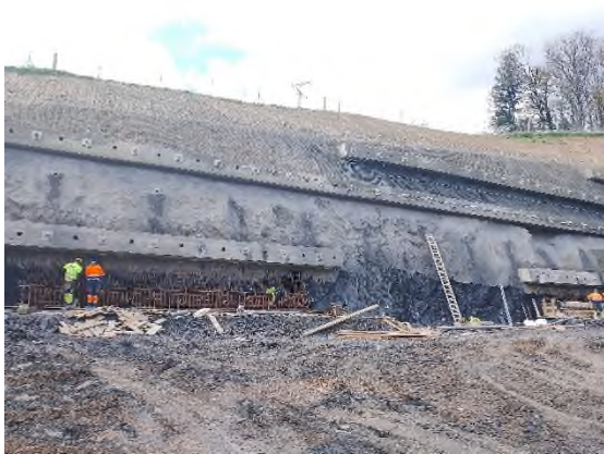
Foto nº7: Sostenimiento emboquille Etxebarria
