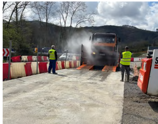
Foto nº26: Uso correcto del lavarruedas en la zona de Etxebarria
