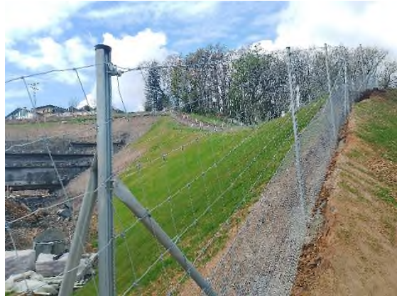
Foto nº6: Eje 21. Cerramiento Etxebarria
