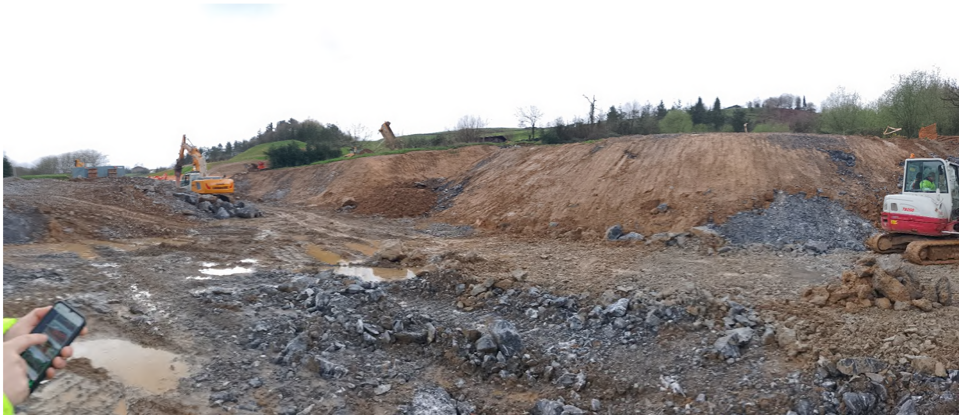
LABORES EXCAVACIÓN EJE30
