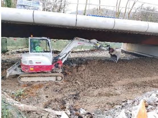
Foto nº3: Extendido de tierra vegetal Estructura-1
