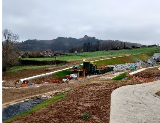
Foto nº4: Extendido de tierra vegetal eje-24
