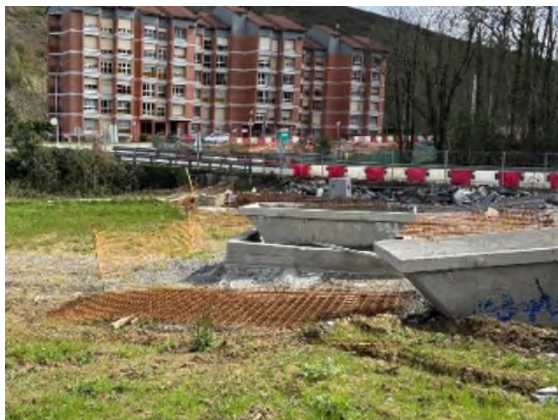
Foto nº27: Lavado de canaletas en Etxebarria
