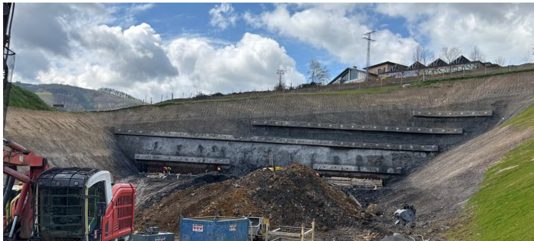
Foto nº40: Hidrosiembra emboquille Etxebarria
