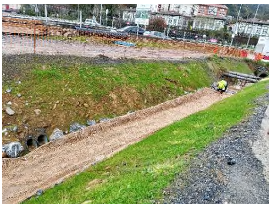
Foto nº31: Instalación malla yute en ODT-02
