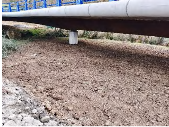
Foto nº38: Zona restaurada tras en fin de trabajos en la zona.
